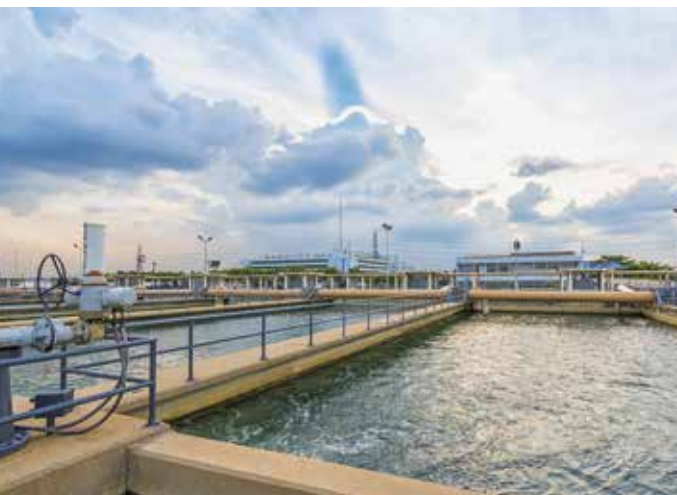
Depuradoras - E.D.A.R. - E.T.A.R.
